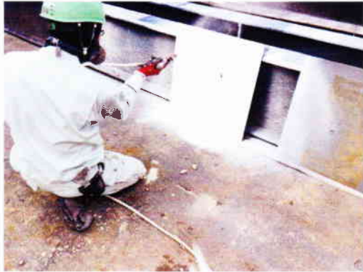
写真-1 試験体作成状況
