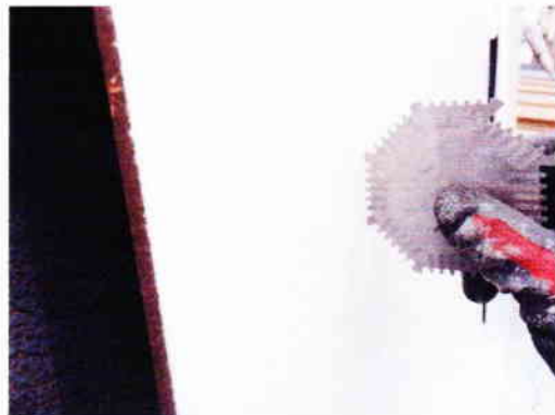
写真-2 ウェット膜厚の測定状況
